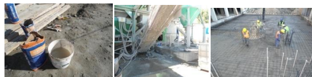
Figure 2.2.1.1: a); b);c);d) Concrete production site
