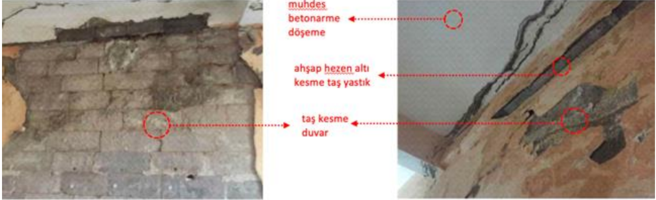
Figure 15. Özgün ve muhdes yapı elemanları (Uzaslan,2021).
